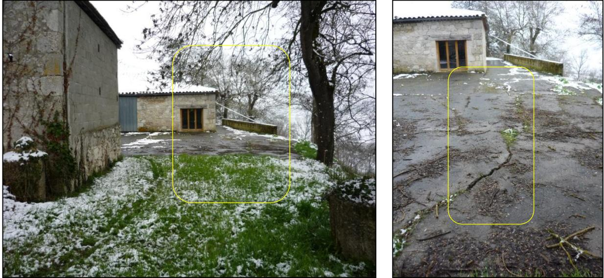
**Figure 23 :** Fissuration importante de la dalle en bordure du versant, à l'entrée du village [Source : IMS<sub>RN</sub>]
