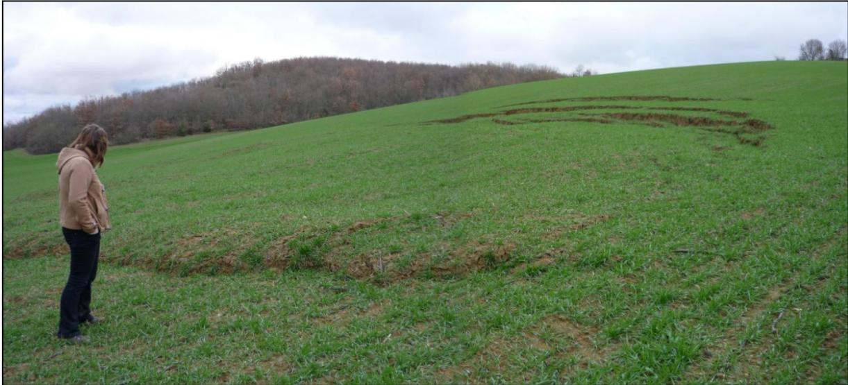
Figure 20 : Glissement superficiel à la Ritonne, sur la commune de Castelsagrat [Source : IMS<sub>RN</sub>]
