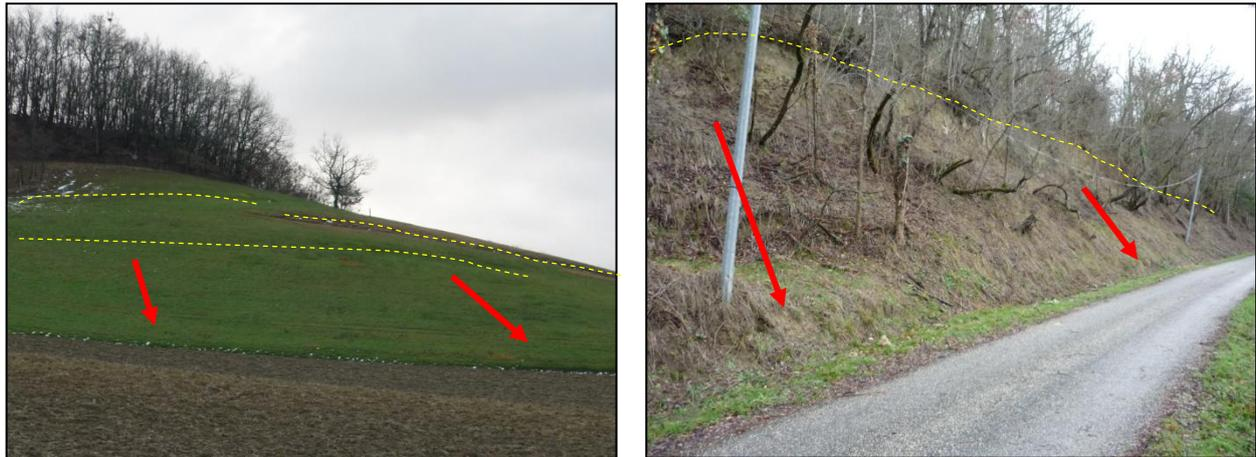
**Figure 21** : Légères ruptures de pente dans le versant au Nord de Ladogne (à gauche) et loupe de glissement dans un talus routier, en amont de Merlet (à droite) [Source : IMS<sub>RN</sub>]
